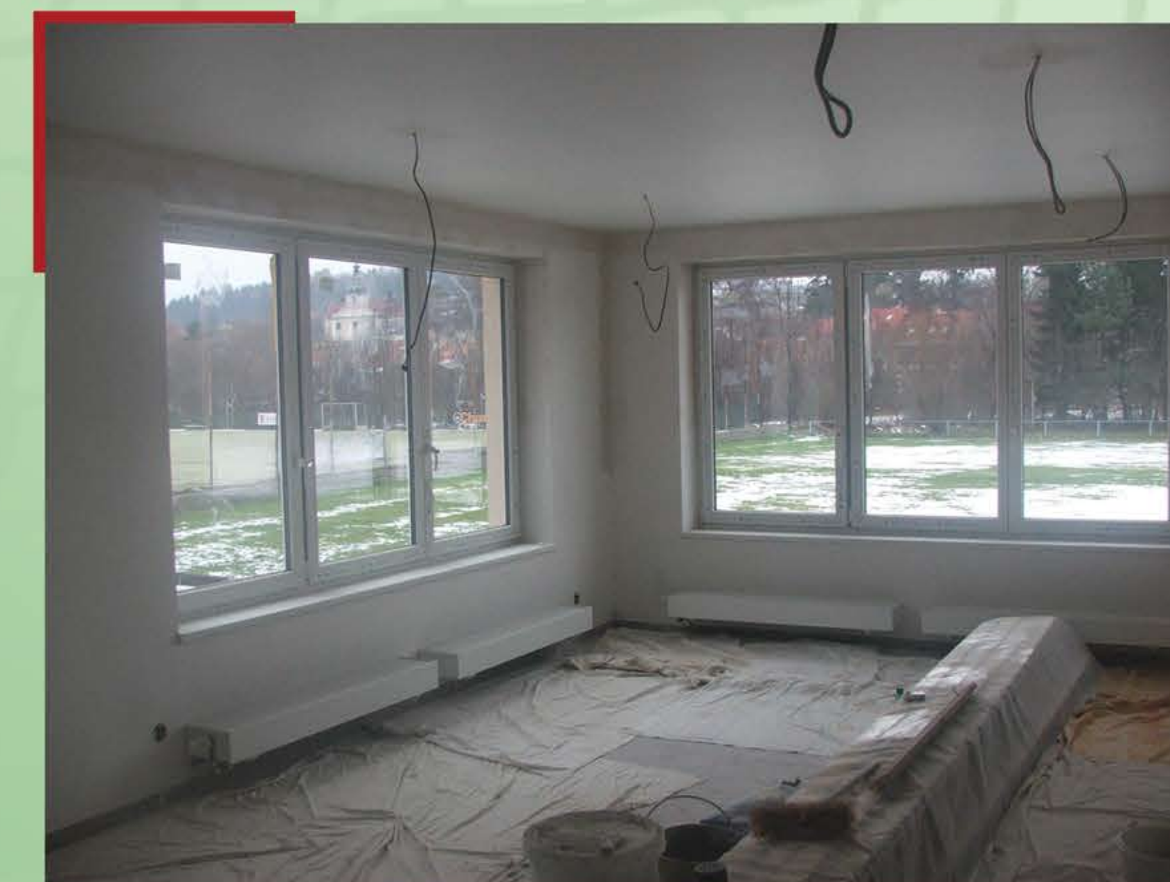
stavba nových kabin zasedačka
