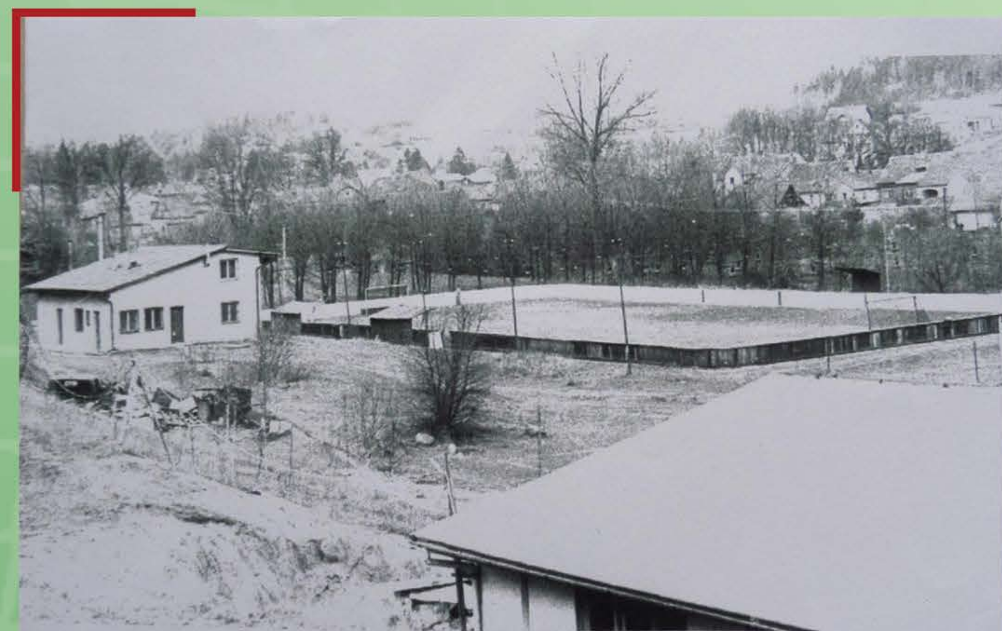
Hřiště a mantinely pro lední hokej a kabiny oddílu pozemního hokeje
